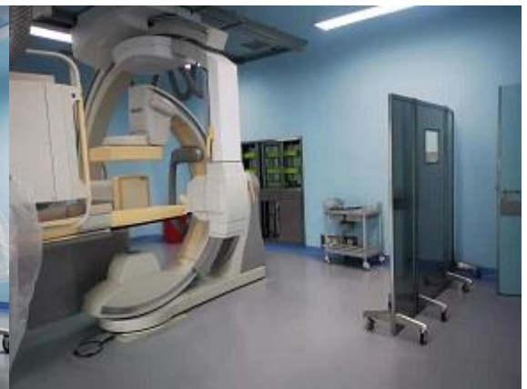
导管室 2 防护设施和铅屏风
